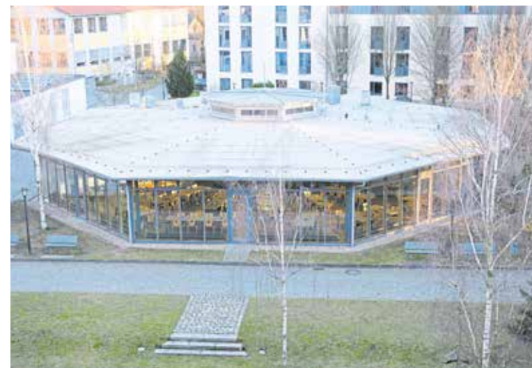
Die Mensa auf dem Gelände der Handwerkskammer Dresden. Das Gebäude von 1996 wird saniert. Foto: Daniel Bagehorn
