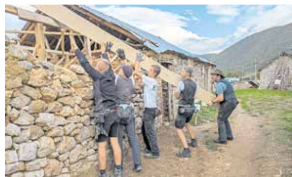
Anpacken war gefragt, um den zum Teil ruinösen Zustand des Hauses zu retten und das Dach aufzusetzen.
