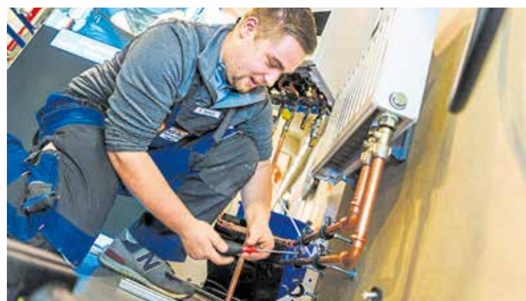
Handwerk zum Anfassen: Azubi Paul Domsch zeigte Jugendlichen, worauf es beim Installieren von Zu- und Abläufen einer Heizung ankommt.
